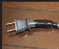
●電気コード被覆の補修
