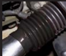
●ダクト類の補修
