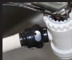
●洗面所、キッチン等の水回り補修
